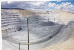
Die Toromocho-Mine liegt in einer Höhe von 4.800 m
