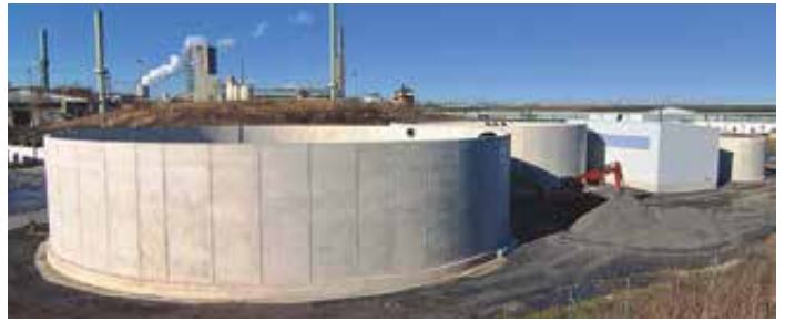
Neue Regenrückhaltebecken am Standort Lünen
