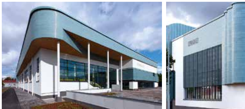
Prämiertes Kupfer-Solar-Fassadensystem am Schwimmbad in Pori
